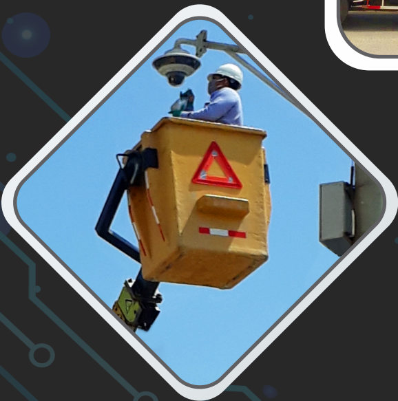
Mantenimiento y Montaje de Equipos
