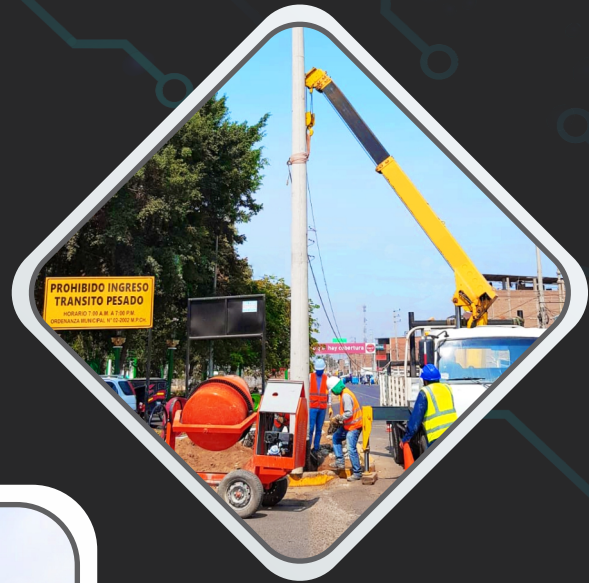
Izaje de postes
